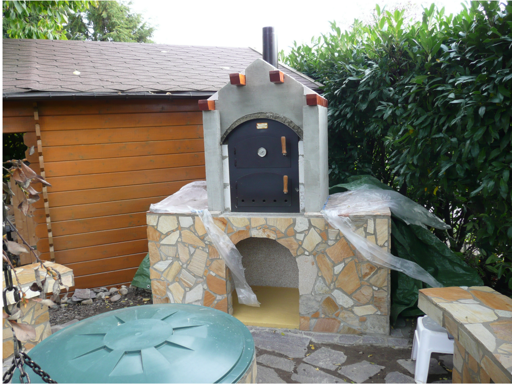
Verputzen mit Netzgewebe
