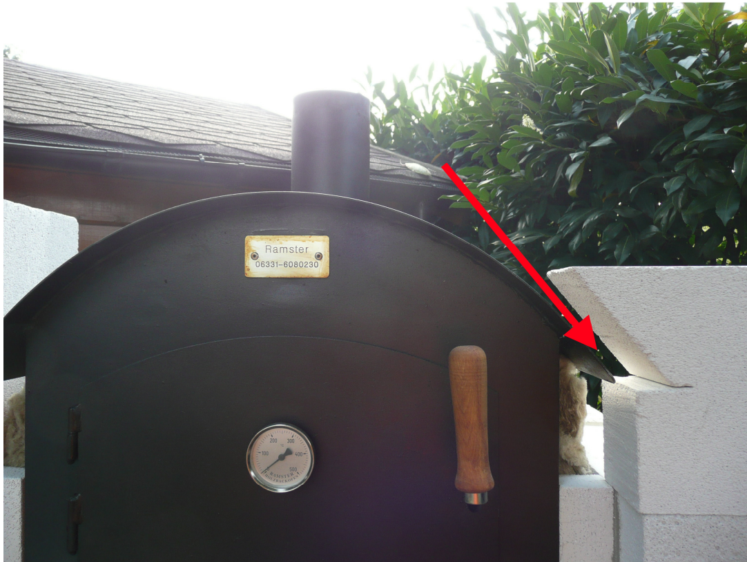
Ytong am Ramsterdach anpassen (Ecken aussägen)
