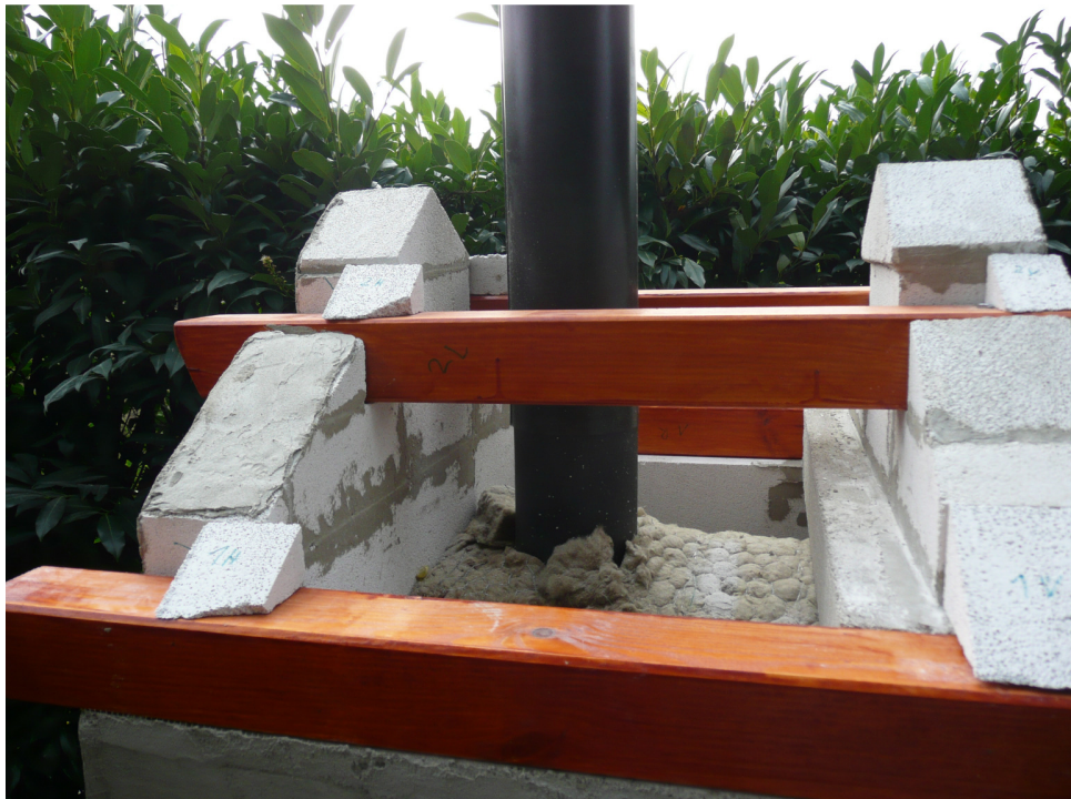
Dachbalkenaussparungen. Ofenrohr selbstverständlich auch isolieren mit Isover!
