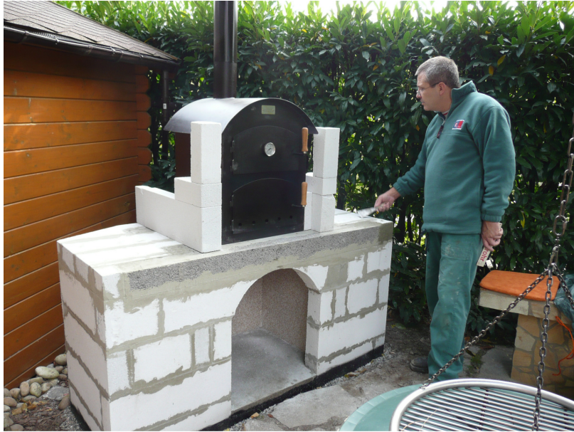
Ramster auf die Betonstürze gestellt. Hitzeableitung nach unten. Hochmauern!
