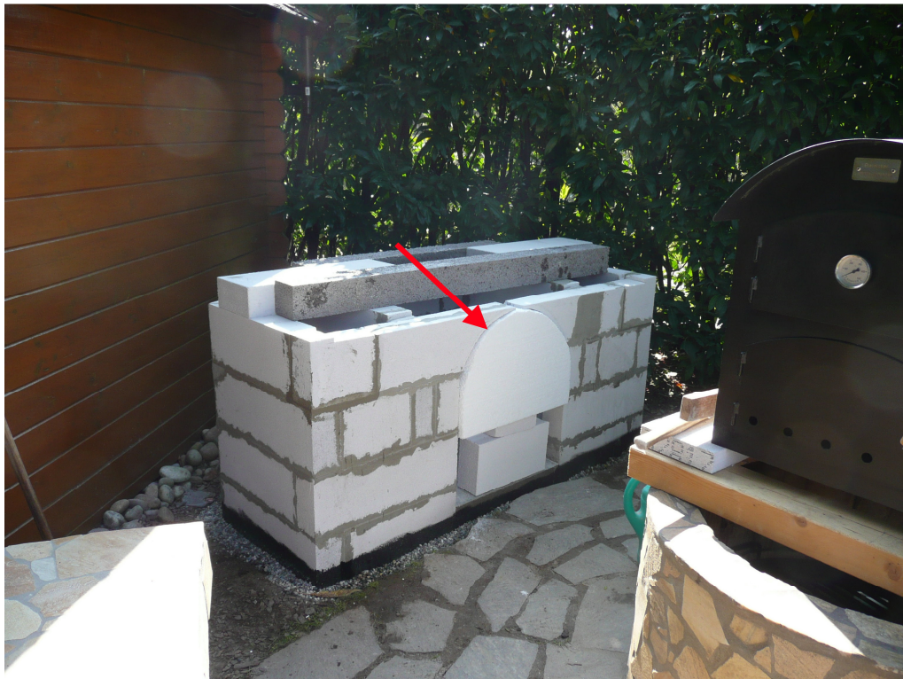
Styroporbogen nur als Unterstützung für Betonsturz eingefügt. Ytongsteine einfach mit dem Fuchsschwanz bzw. Stichsäge aussägen!
