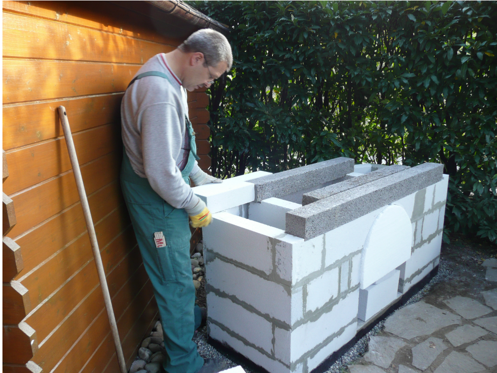
Betonsturz über Styroporbogen
