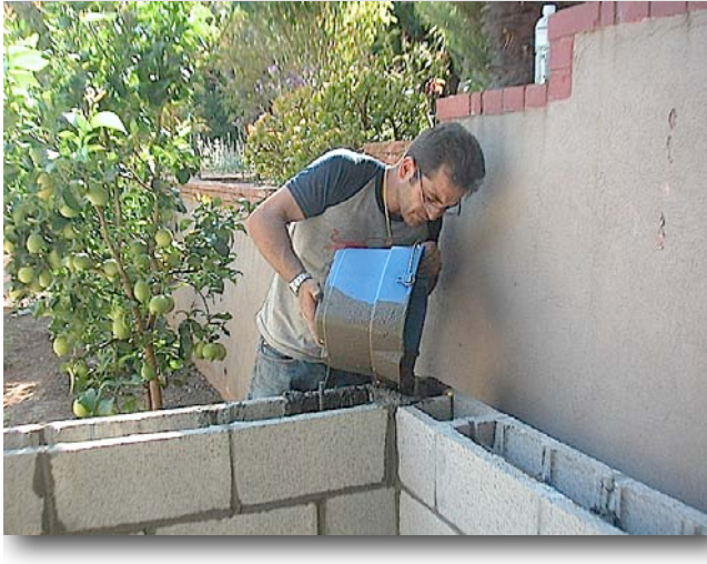
2.8. Filling the cores.
